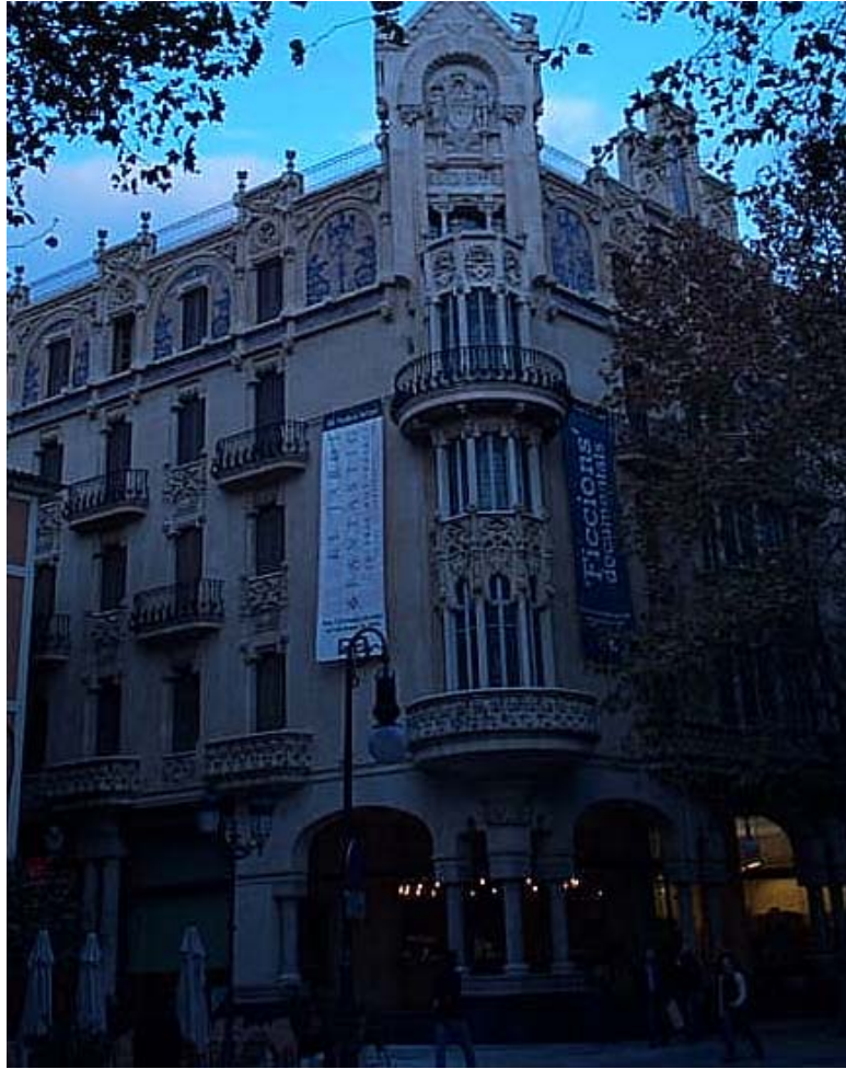
Façana principal del Gran Hotel.
